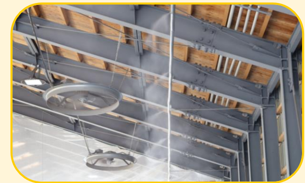
↑ この施設の牛舎の天井には、消毒液が噴霧される装置があり、定期的に噴霧することで衛生管理を徹底しています。
