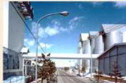
連絡転送設備
